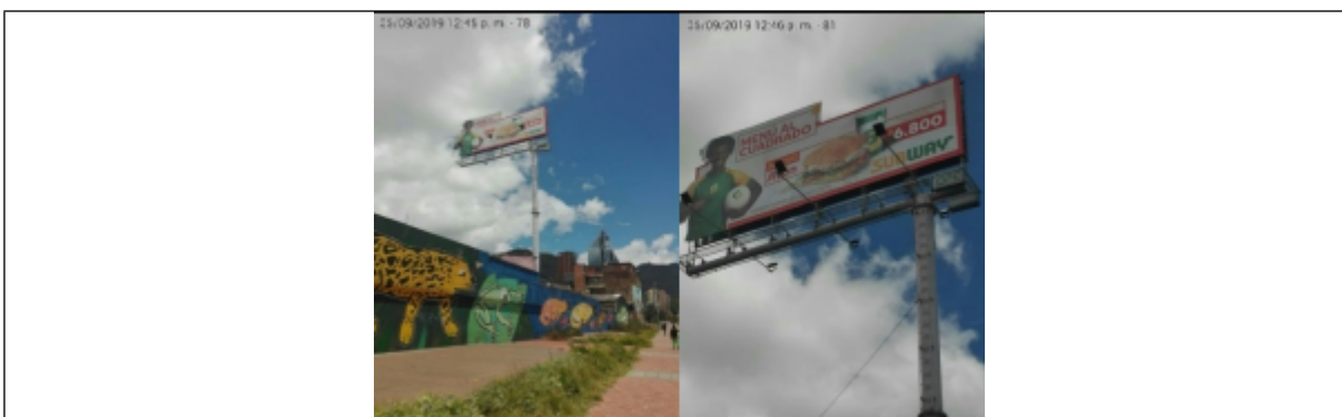
Foto No.1 y 2: Vista panorámica del predio y de la estructura de la valla ubicada en la Calle 27 No. 20A-51 (dirección catastral), orientación Oeste-Este.
